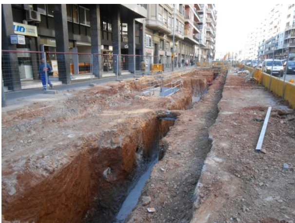
FOTO 17. Rasa executada al tram 2
