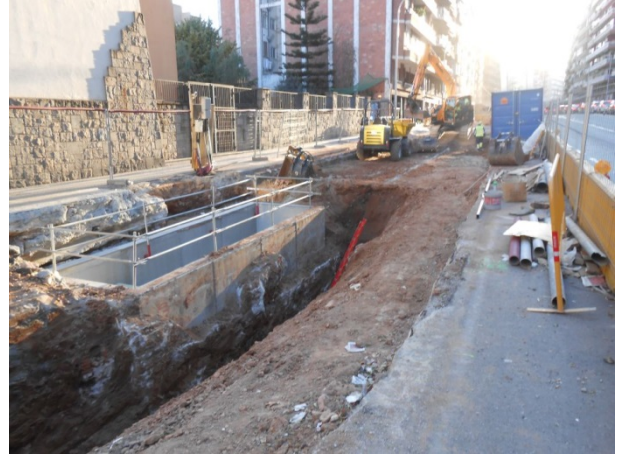
FOTO 24. Situació del tram 6 a l'inici del control arqueològic
