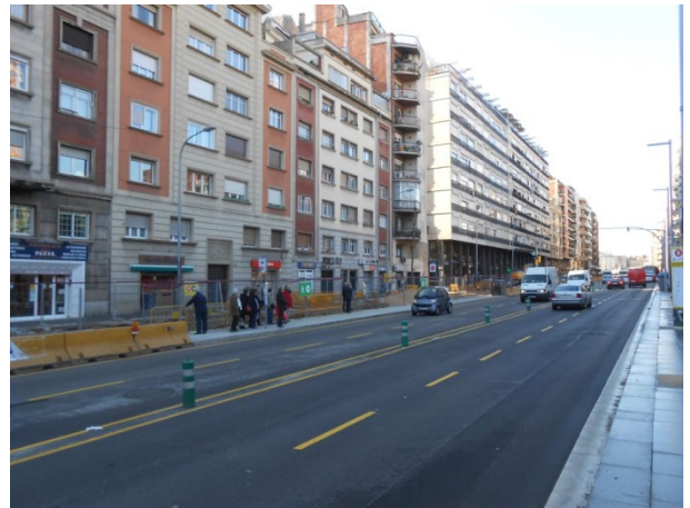
FOTO 04. Situació inicial a 18 de novembre de 2016. Tram 3
