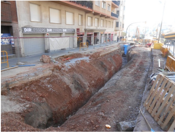
FOTO 13. Rasa al tram 1
